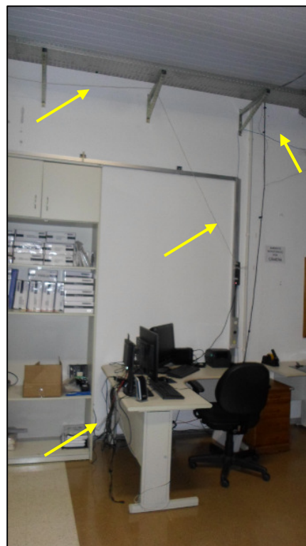
Foto 40 – Prédio Forum - Depósito Informática. Instalação elétrica inadequada.
