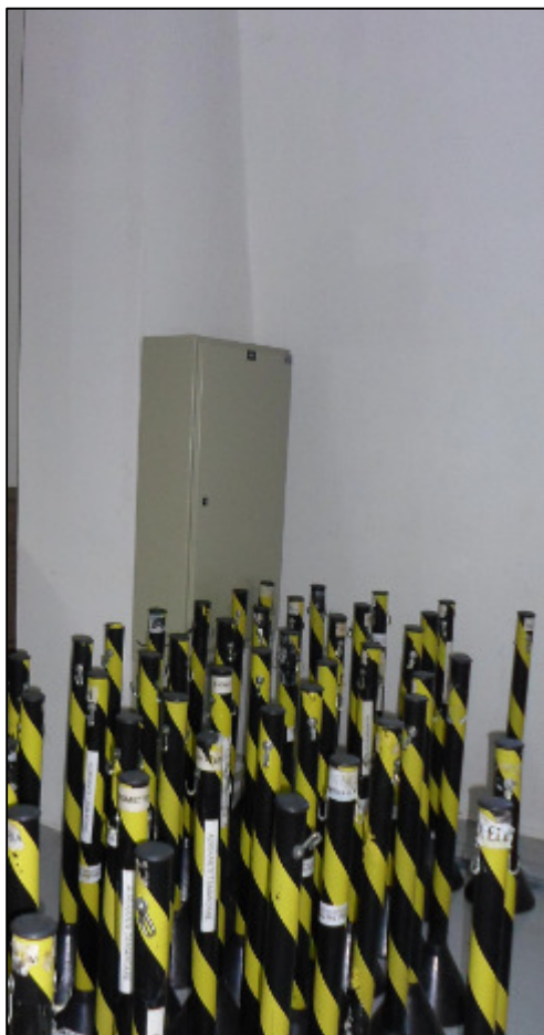
Foto 37 – Prédio Sede (depósito Logística) e Forum (depósito informática) - Obstrução do acesso aos quadros elétricos em caso de emergência.
