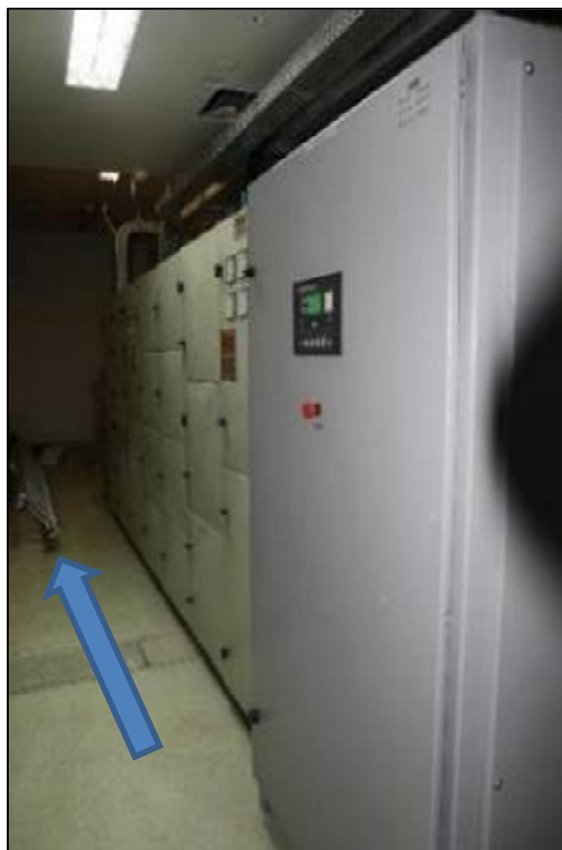
Foto 59 - Recomendação de Recobrimento do piso com tapete isolante e retirada da escada do local.
