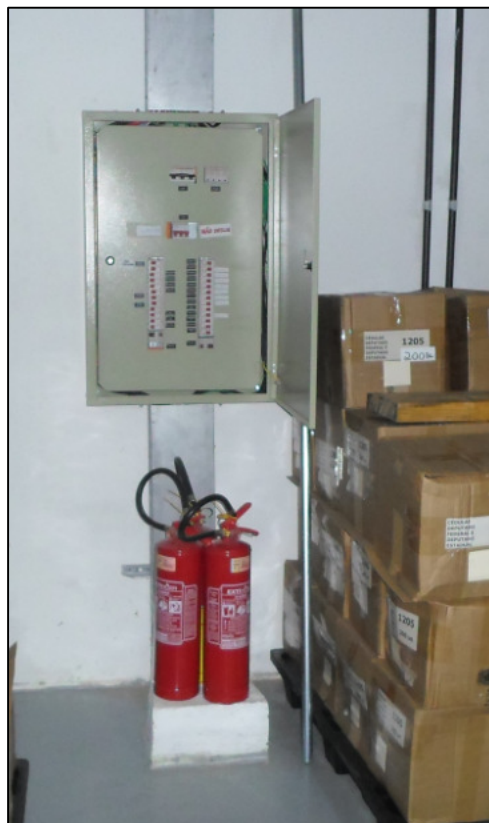
Foto 45 – Prédio Sede. Extintores em local inadequado. Não devem obstruir o acesso ao quadro elétrico e devem ser dispostos a 1,80 metros do solo conforme NPT 020 – SINALIZAÇÃO DE EMERGÊNCIA do corpo de bombeiros do PR.
