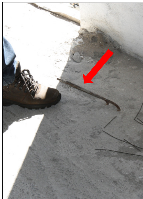
Foto 34 – Fórum. Casa de máquinas elevador 1 Ferragem exposta da laje. Risco de acidentes.
