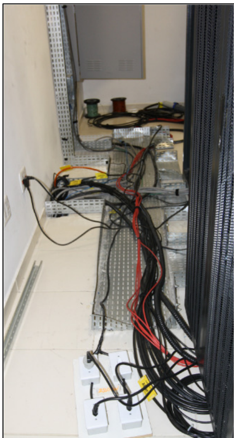
Foto 29 – Fórum. SETI Racks – Instalações inadequadas, obstrução dos quadros elétricos, desorganização, materiais combustíveis espalhados por toda a sala. Risco de incêndio.
