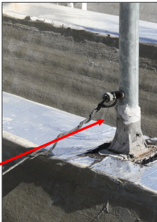
Foto 53 – O sistema de SPDA apresenta partes oxidadas e soltas.
