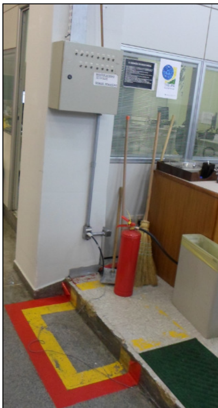
Foto 45 – Prédio Sede. Extintores em local inadequado. Não devem obstruir o acesso ao quadro elétrico e devem ser dispostos a 1,80 metros do solo conforme NPT 020 – SINALIZAÇÃO DE EMERGÊNCIA do corpo de bombeiros do PR.
