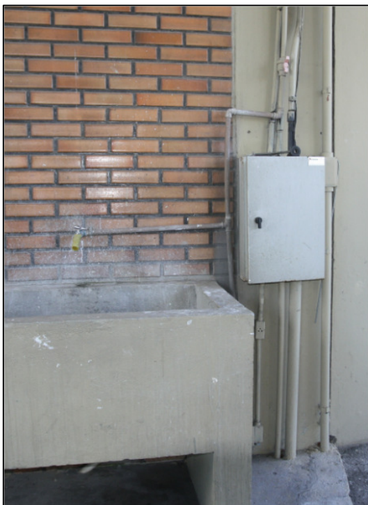
Foto 17 – Prédio Sede - Quadro elétrico em área úmida. Notar o interruptor DR desligado. Este dispositivo é obrigatório em áreas externas a edificação segundo a NBR 5410.
