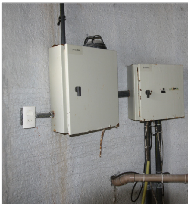
Foto 26 – Fórum. Caixa d'água. Substituição dos dois quadros e renovação das instalações que sem encontram sem proteção e identificação adequada. Risco de incêndio.
