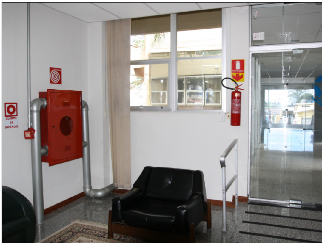
Foto 42 – Prédio Sede - Entrada da Corregedoria. Sistema de proteção contra incêndio em local inadequado e ausência da sinalização de solo para equipamentos de combate a incêndio (1,0x1,0m) conforme NPT 020 – SINALIZAÇÃO DE EMERGÊNCIA do corpo de bombeiros do PR.
