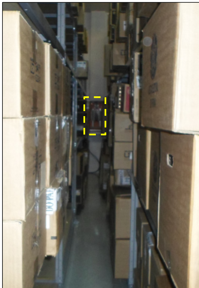
Foto 37 – Prédio Sede (depósito Logística) e Forum (depósito informática) - Obstrução do acesso aos quadros elétricos em caso de emergência.
