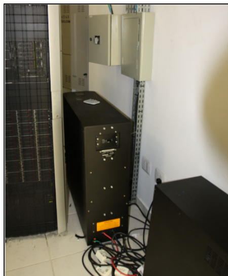
Foto 29 – Fórum. SETI Racks – Instalações inadequadas, obstrução dos quadros elétricos, desorganização, materiais combustíveis espalhados por toda a sala. Risco de incêndio.
