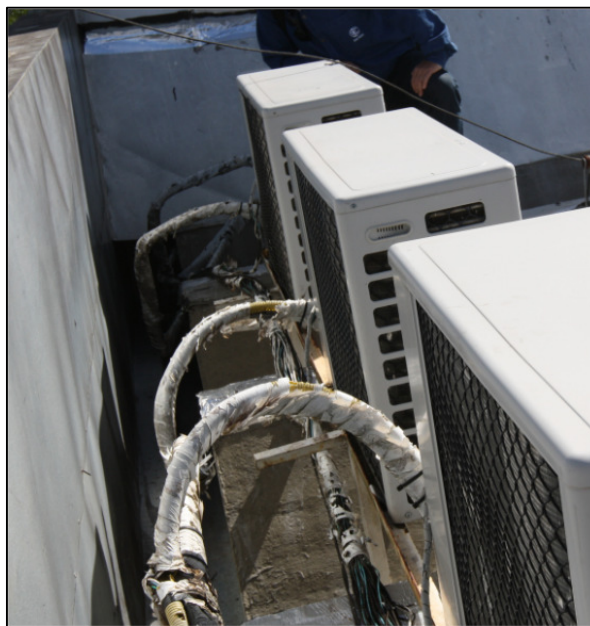
Foto 32 – Fórum. Cobertura – Instalações inadequadas dos equipamentos de ar condicionado. Fiação exposta a intempéries.
