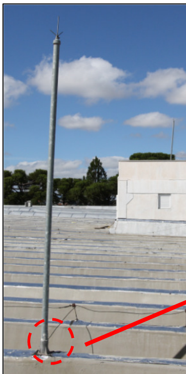
Foto 53 – O sistema de SPDA apresenta partes oxidadas e soltas.
