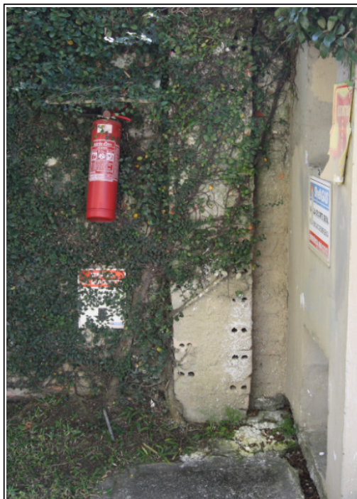
Foto 43 – Prédio Sede. Sistema de proteção contra incêndio em local inadequado.
