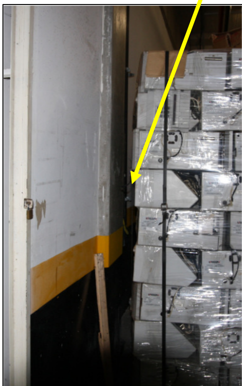
Foto 28 – Fórum. Depósito. Obstrução do quadro elétrico e instalações em péssimas condições.
