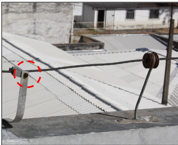
Foto 53 – O sistema de SPDA apresenta partes oxidadas e soltas.
