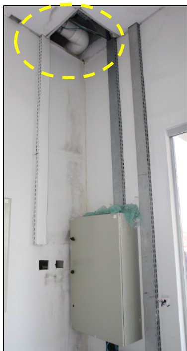
Foto 16 – Prédio Sede - Próximo à sala de Manutenção Vazamento sobre o quadro, sujeira e instalações inadequadas.
