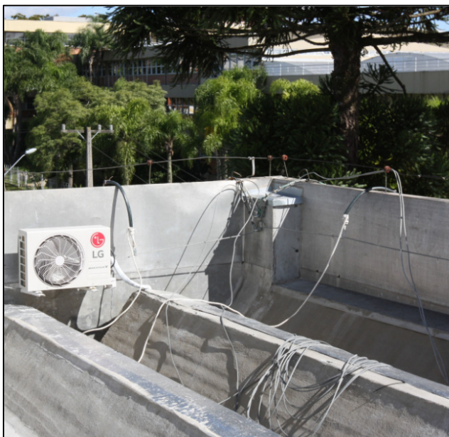
Foto 31 – Fórum. Cobertura – Instalações de segurança dos funcionários de forma inadequada e danificando as instalações de para-raios e ar condicionado.
