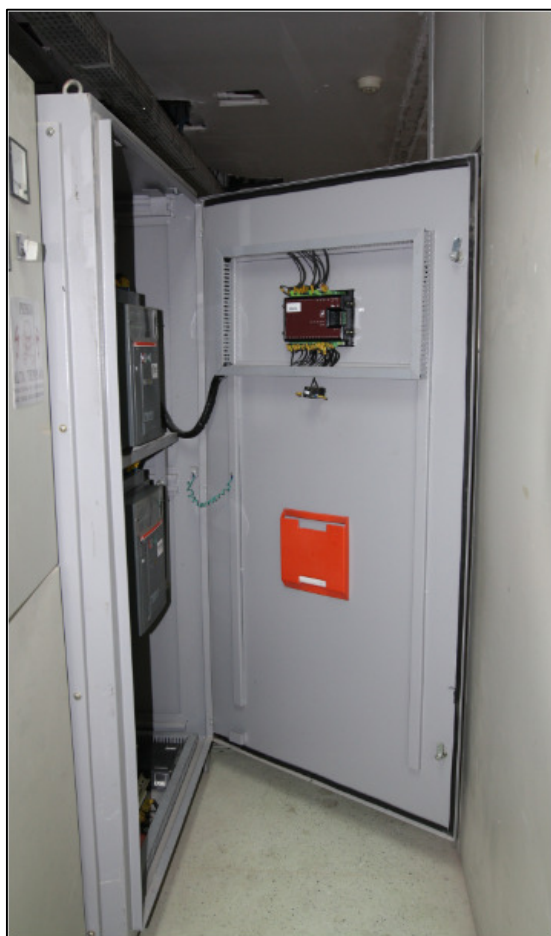
Foto 12 – Prédio Sede - Sala de alta tensão – Restrição de abertura da porta de acesso ao quadro.
