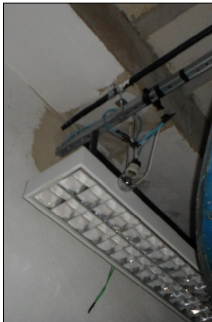
Foto 35 – Anexo ao prédio Sede - Cisterna de Combate à incêndio do centro de logística com instalações elétricas precárias e confusas.
