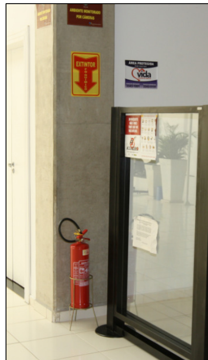
Foto 44 – Fórum. Sistema de proteção contra incêndio em local inadequado.
