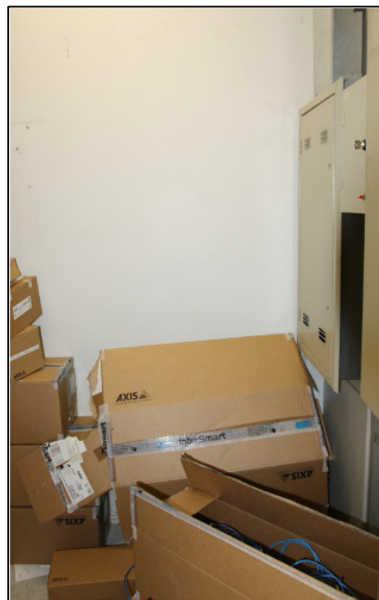
Foto 21 – Prédio Sede – Resto de material e diversas caixas impedindo o acesso aos quadros elétricos próximo ao Banco do Brasil.
