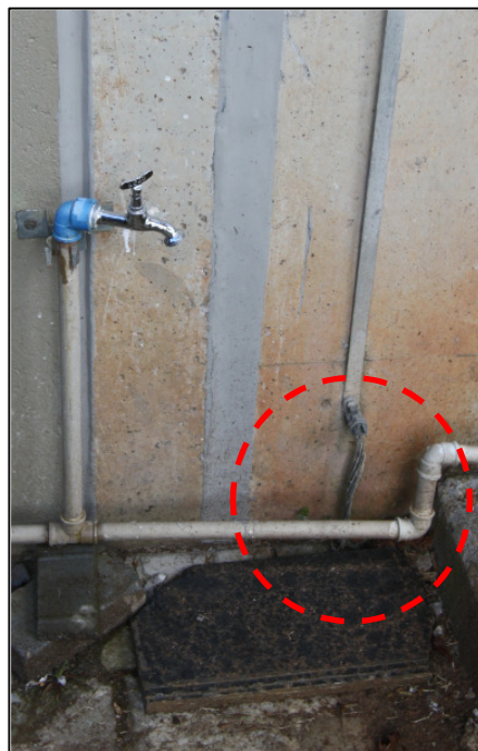
Foto 57 – Torneira instalada em local inadequado e próximo ao sistema de SPDA.
