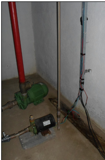
Foto 35 – Anexo ao prédio Sede - Cisterna de Combate à incêndio do centro de logística com instalações elétricas precárias e confusas.
