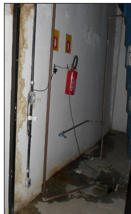
Foto 36 – Anexo ao prédio Sede . Cisterna de Combate à incêndio do centro de logística com instalações elétricas precárias e confusas.
