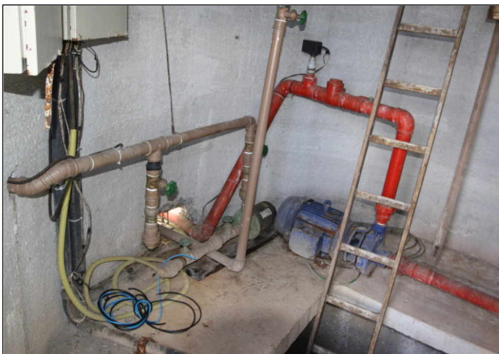
Foto 27 – Fórum. Caixa d'água. Local inadequado para manutenção. Risco de acidente.
