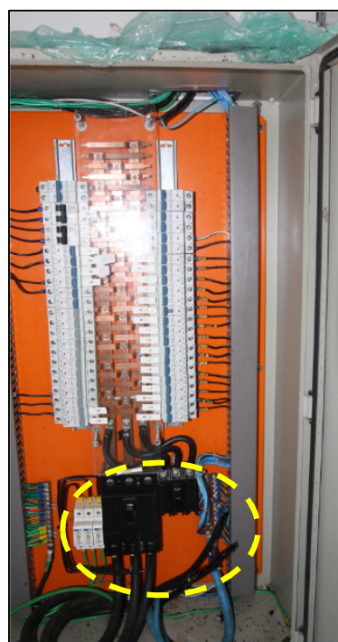
Foto 16 – Prédio Sede - Próximo à sala de Manutenção Vazamento sobre o quadro, sujeira e instalações inadequadas.
